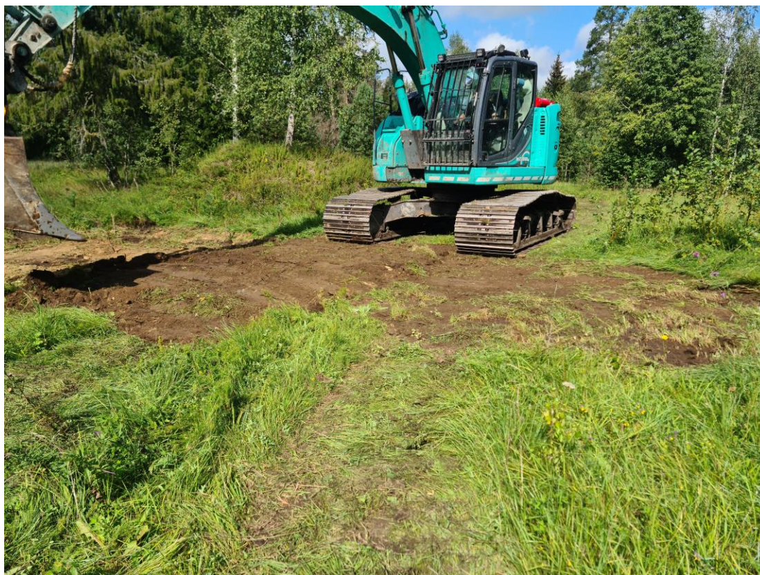
Foto 4.1. Kaevandid rajati ja likvideeriti 23-tonnise roomikekskavaatoriga KOBELCO SK230SR (kaevand K-20) (foto S. Siir, 25.08.2023, N 58°57'34", E 24°55'59").
